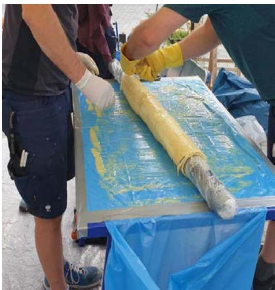
Zur Reparatur einer Schadstelle in einem Rohr bereiten Mitarbeitende einen Kurzliner vor. Der Schlauch aus Filz oder Glasfaser wird in Harz getränkt und anschließend in das Rohr zur Schadstelle geschoben.
