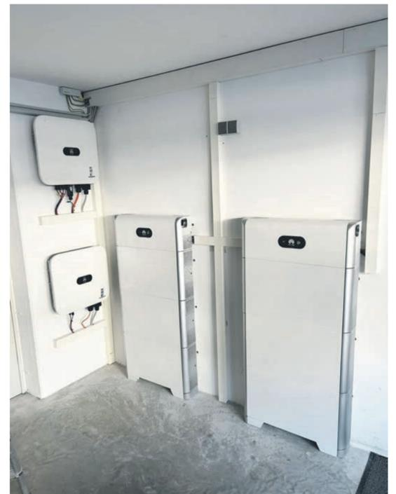
Ein Blick ins „Herz“ der Solaranlage: Die Wechselrichter (links an der Wand) und die Speicher (rechts) verwandeln den von den Modulen auf dem Dach produzierten Strom. Dabei nehmen sie nur minimalen Platz in Anspruch.
