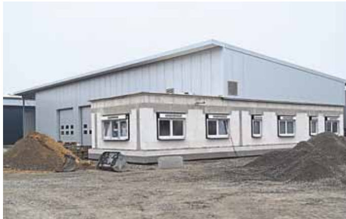
Der Bauhof-Neubau wird den kommenden Rohrheimer Haushalt mit rund 90.000 Euro belasten. Foto: Burmeister
