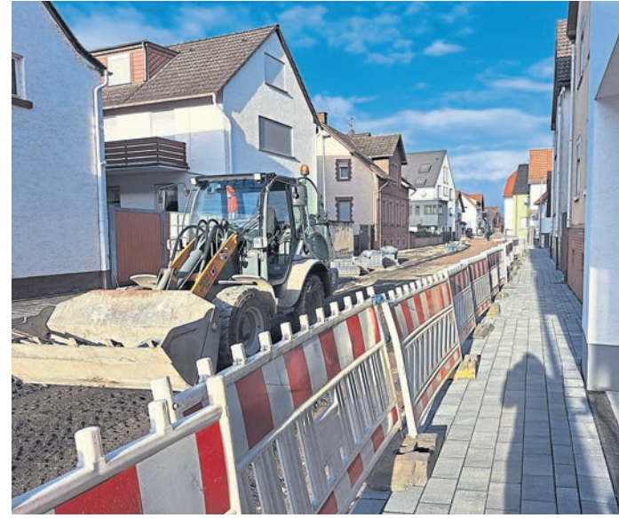
Die Pfützenstraße wird weiter grundhaft saniert. Ab Ende Dezember ruhen die Arbeiten allerdings für einige Wochen, so die Stadtverwaltung. Foto: Stadt Griesheim
