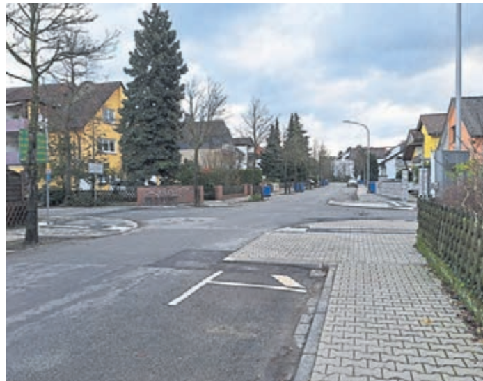
Entlang der geplanten Fahrradstraße in der Goethestraße werden sogenannte „Gehwegnasen“ an Kreuzungsbereichen gebaut, damit Fußgängerinnen und Fußgänger eine bessere Übersicht über den Straßenverkehr bekommen.
