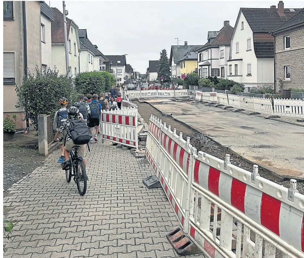
Die Bahnhofstraße am Freitagmorgen gegen 7.15 Uhr, kurz vor Schulbeginn. Die Schülerinnen und Schüler müssen sich hier zu Fuß und mit dem Rad durch Engstellen zwängen, die durch die Bauarbeiten entstehen. Besonders für die neuen Erstklässler ist das nicht einfach, denn viele kennen ihren Schulweg noch nicht. Die Gehweg- und Straßenbauarbeiten sollen laut Mitteilung der Stadtverwaltung noch bis zum 18. Oktober andauern. Foto: Privat
