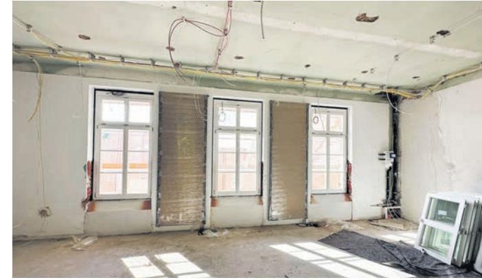
Hier entsteht ein Gruppenraum für die künftige Kita-Nutzung der Alten Schlossschule in Gräfenhausen. Die Arbeiten schreiten fort und Ende dieses Jahres soll das Gebäude fertiggestellt sein. Foto: SPD-Fraktion
