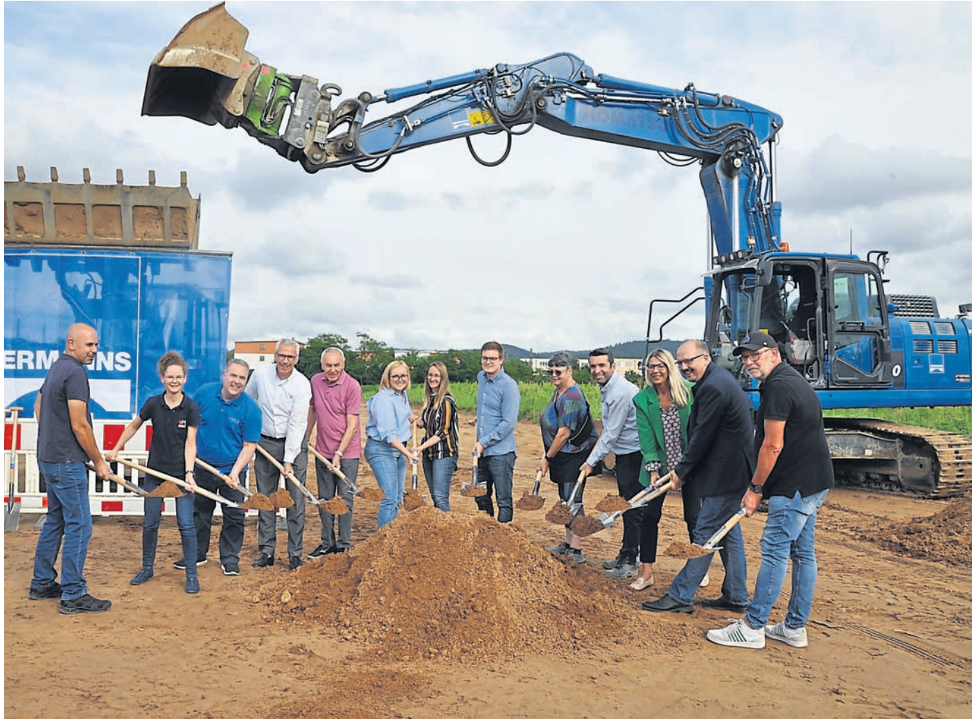
In Bickenbach fand kürzlich der Spatenstich zum neuen Gewerbegebiet „In der Delle“ im Beisein von Bürgermeister Markus Hennemann (Zweiter von rechts) statt. Das Gewerbegebiet hat eine Fläche von 6,1 Hektar. Foto: Flasche
