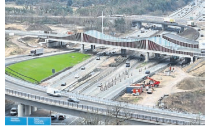
Aufgrund von Instandhaltungsmaßnahmen entfällt von Samstag auf Sonntag die Einfahrtmöglichkeit über die A672 auf die B26 nach Darmstadt. Das Foto zeigt die neue Brücke am Darmstädter Kreuz. Foto: Autobahn GmbH
