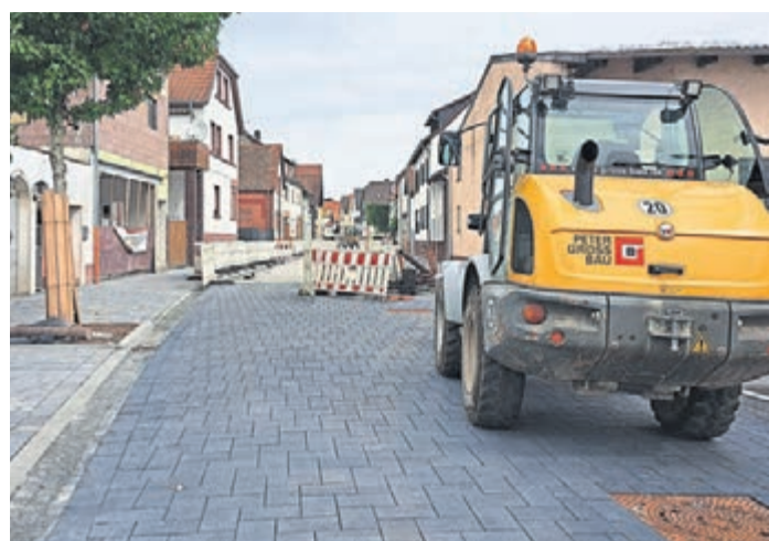
Die Stadt Griesheim zeigt sich mit dem Baufortschritt in der Pfützenstraße zufrieden. Foto: Stadt
