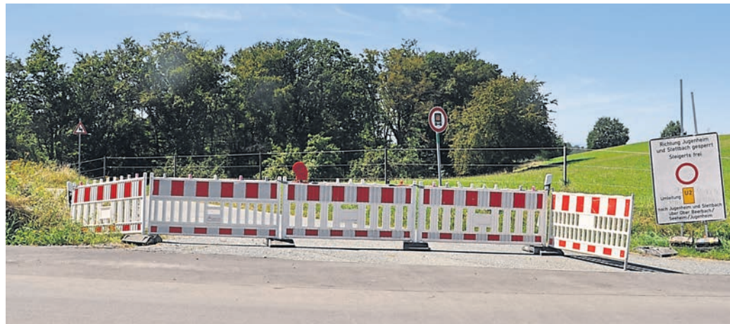
Die Sperrung der Höhenstraße zwischen Steigerts, Stettbach und Ober-Beerbach stellt Anwohnerinnen und Anwohner vor große Herausforderungen. Im Jahr 2025 sollen die Sanierungsarbeiten beginnen. Fotos (2): Flasche
