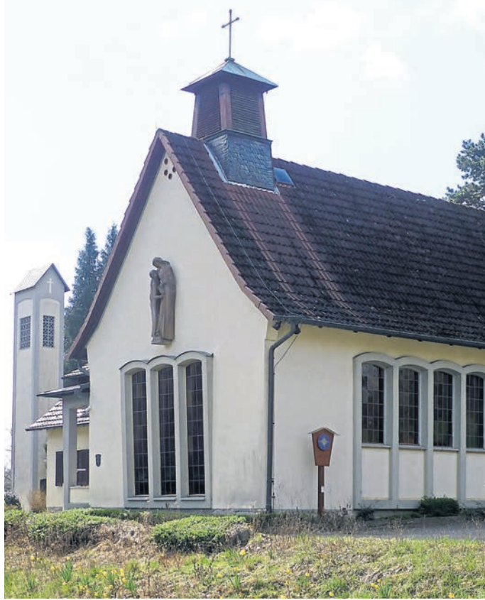
Die katholische Kirche St. Elisabeth in Schönberg wurde 2019 entsakralisiert. Ein Verein katholischer Gläubiger aber führt dort inzwischen wieder Gottesdienste durch und setzt sich in einer Petition für die Rückkehr der entfernten Glocken nach Schönberg ein.
